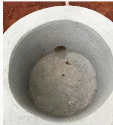
Figura: Confeção da entrada do substrato com tubo PVC de 100 mm.
