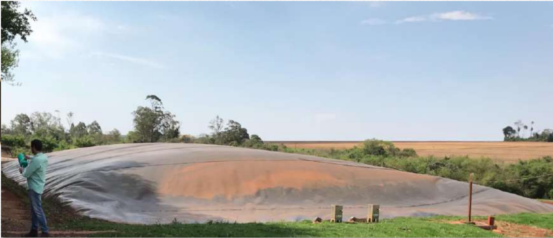
Figura: Biodigestor tipo lagoa coberta para tratamento de efluente suíno e produção de energia elétrica a partir de biogás. Nova Santa Rosa, Paraná. 2018.
