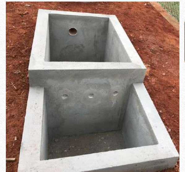
Figura: Confeção da saída do digestado com separação líquido-sólido.
