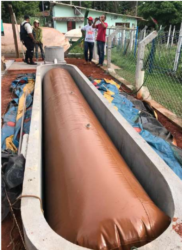
Figura: Biodigestor tubular para tratamento de esterco bovino e geração de biogás, BiogasLab IFG-UFG, Goiânia, GO, 2019.
