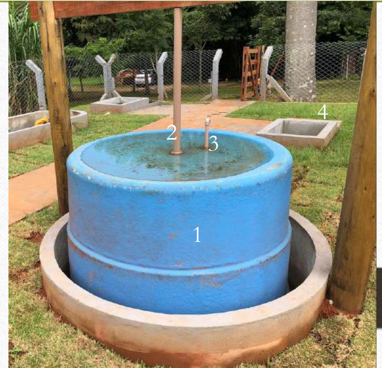
Figura: Digestor Sertanejo com cúpula flutuante (1), cano guia (2) e saída de biogás (3). Reservatório do digestado no fundo a direita (4), tubulação subterrânea. 54
