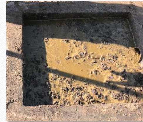
Figura: Digestado saindo do digestor = biofertilizante.
