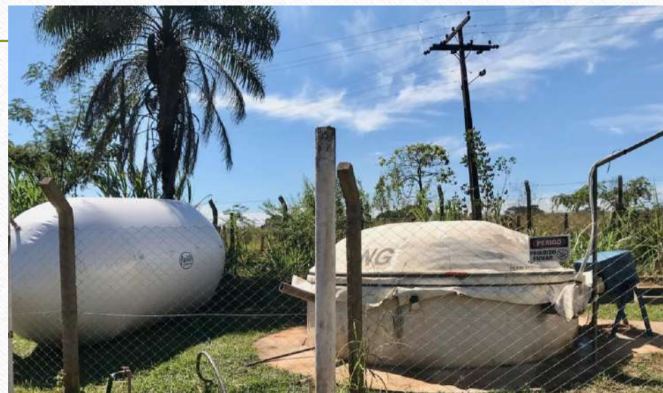
Figura: Biodigestor piloto de cúpula flexível ( Bioreator Brasileiro ) escala piloto com agitação, controle de temperatura e reservatório de biogás (na esquerda), BiogasLab IFG-UFG, Goiânia.
