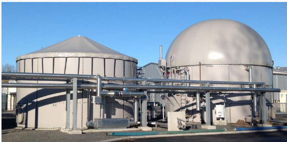
Figura: Biodigestores industriais de cúpula flexível. Bioreatores Alemães . DBFZ (Centro Alemão de Pesquisa em Biomassa), Leipzig, Alemanha. 2018.
