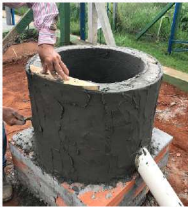
Figura: Confeção da entrada do substrato com tubo PVC de 100 mm.
