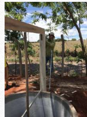
Figura: Digestor Sertanejo com cúpula flutuante (1), cano guia (2) e saída de biogás (3). Reservatório do digestado no fundo a direita (4), tubulação subterrânea. 54
