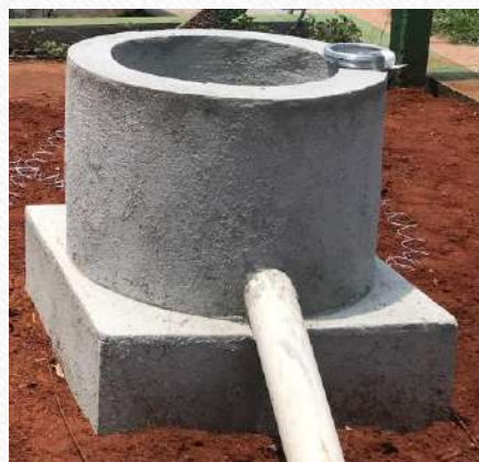
Figura: Confeção da entrada do substrato com tubo PVC de 100 mm.
